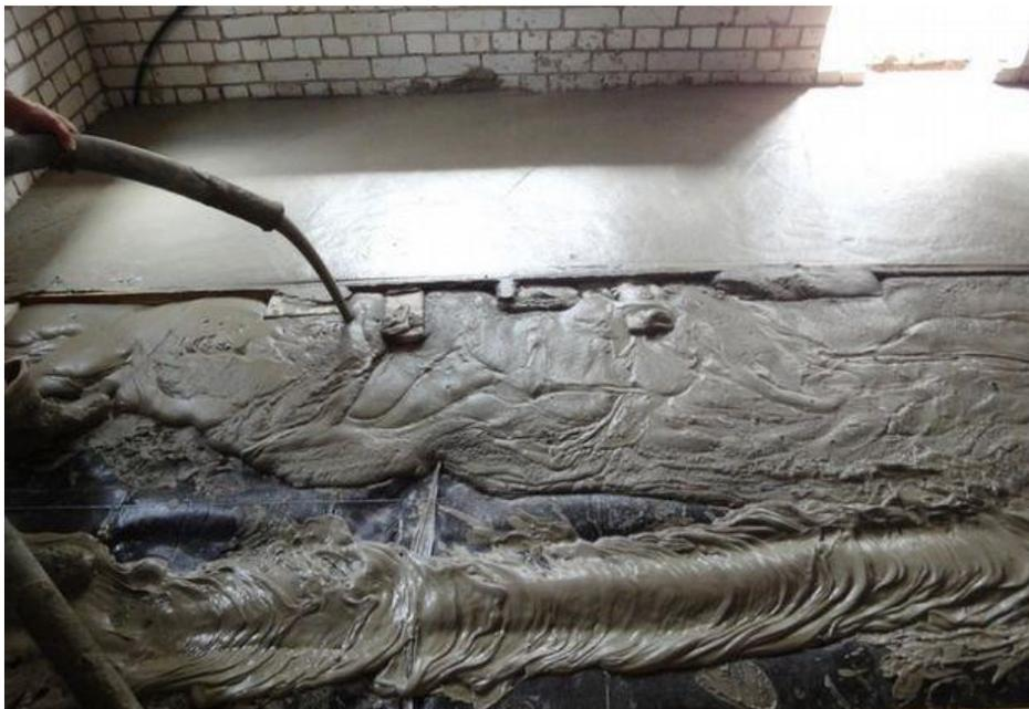
Рисунок 5.3 – Теплоизоляция полов при строительстве индивидуального жилого дома
